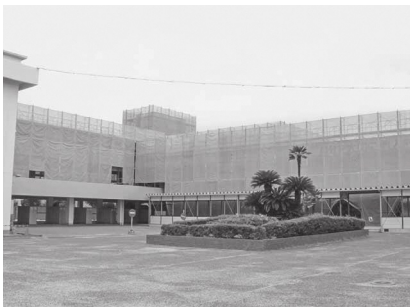
平成30年度の完成に向けて進む 邑久中学校北棟大規模改造工事
