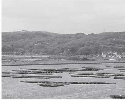
補強工事が完了した錦海湾堤防（手前が錦海湾）
