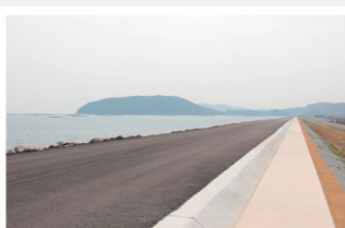
補強工事が竣工した錦海湾堤防(左側が錦海湾)
