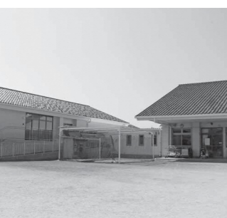
拡張された福田保育園の園舎（右側が既存の園舎）
