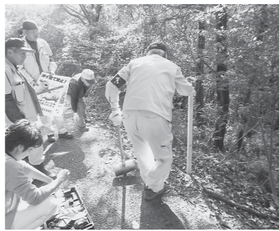
啓発看板を設置するパトロール員
