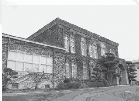
長島愛生園旧事務本館
