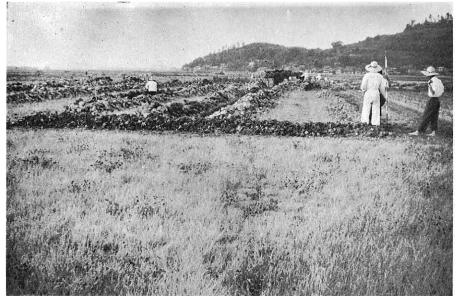
集団暗渠排水作業
