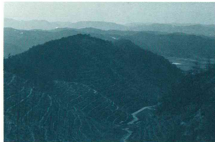
治山砂防工事
