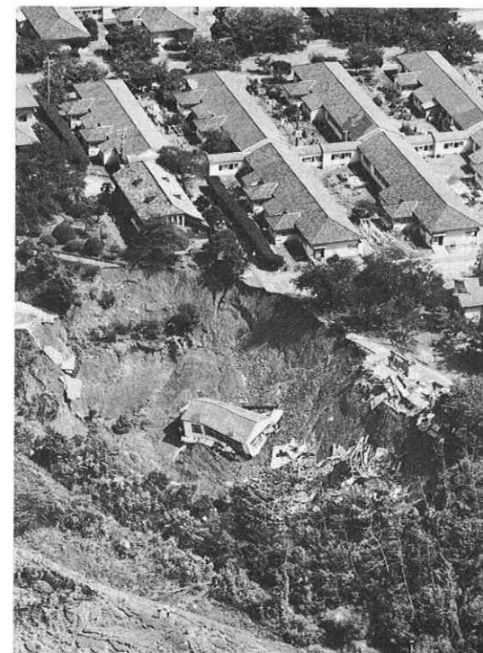
← 邑久光明園の被害状況
