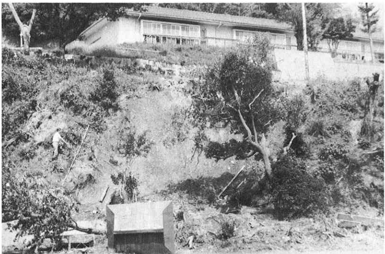
← 蒙掛小学校の法面崩壊
