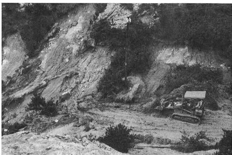
→ 林地の崩壊(町道黒井・虫明線)
