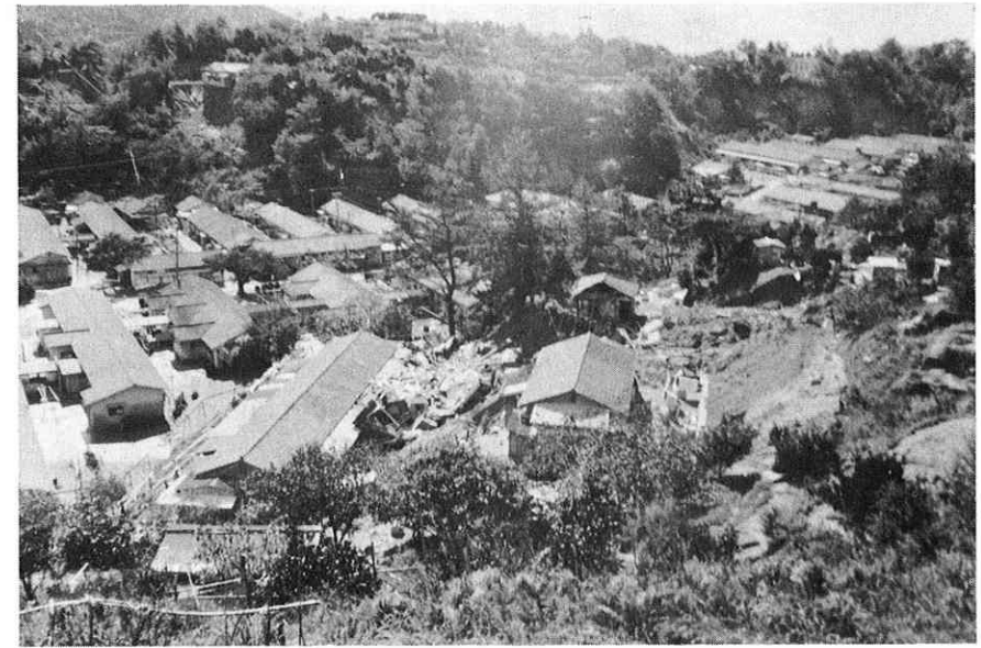
← 愛生園内被災状況
