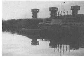
▲福中ポンプ場
