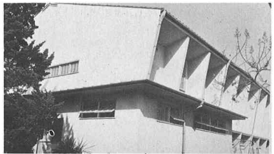
中 学 校 体 育 館
