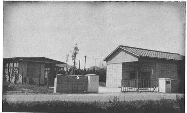
長船町水源地
