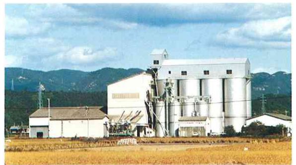
米麦の乾燥調整を一手に引受けるカントリーエレベーター
