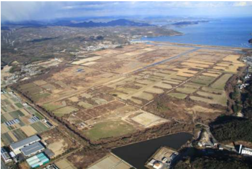
図表 5 錦海塩田跡地を望む航空写真
