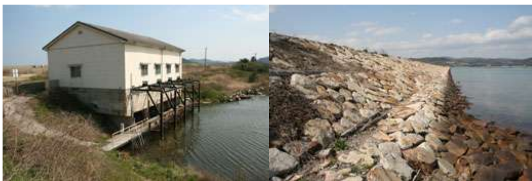
図-3.1-1 排水ポンプ場および錦海湾堤防
