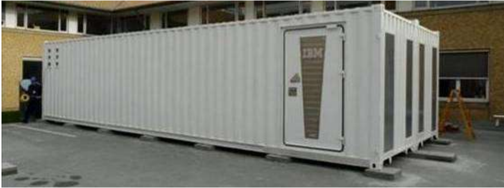
図-2.1.1-9 コンテナ型データセンター
