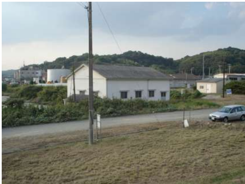
図-3.3.1-2 ポンプ場遠景
