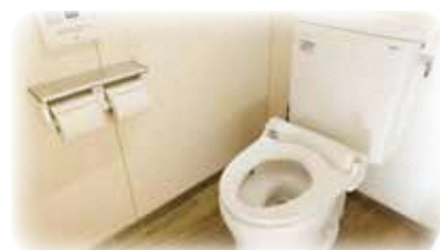
改修工事が終わった行幸小学校のトイレ
