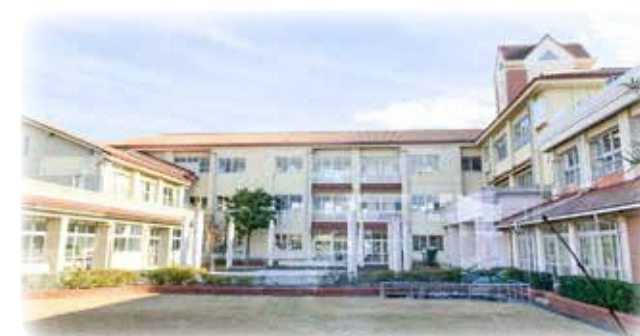
改修予定の国府小学校
