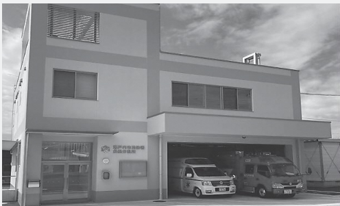
消防署長船分駐所の新庁舎 （長船町土師313-7）
