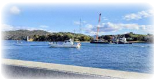
前島への光ファイバー海底ケーブル工事
