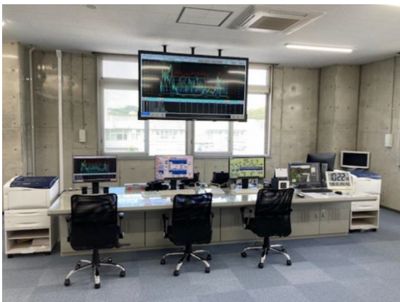
(図 5-2)福山浄水場 中央監視室
