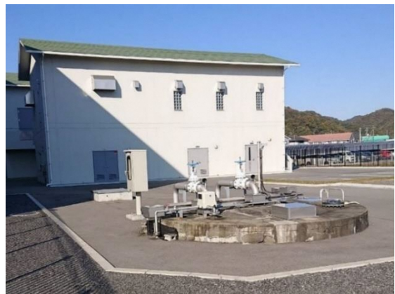
長船水源地 取水井
