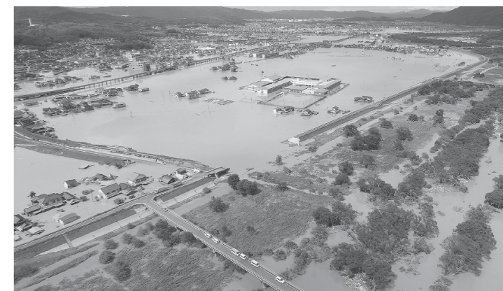
平成 30 年 7 月豪雨災害（倉敷市真備町）での浸水被害
