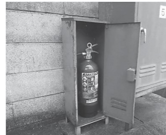
令和4年5月に、本補助金を活用して百田町内会自主防災会が街頭用消火器を整備しました。
