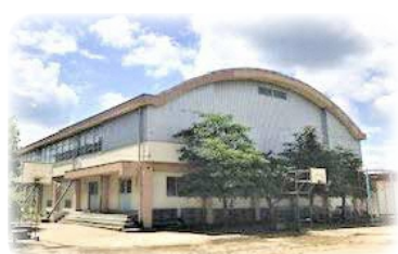
エアコン設置が望まれる学校体育館
