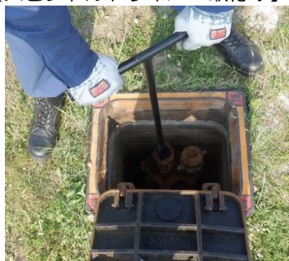
【スピンドルドライバー取付け】
