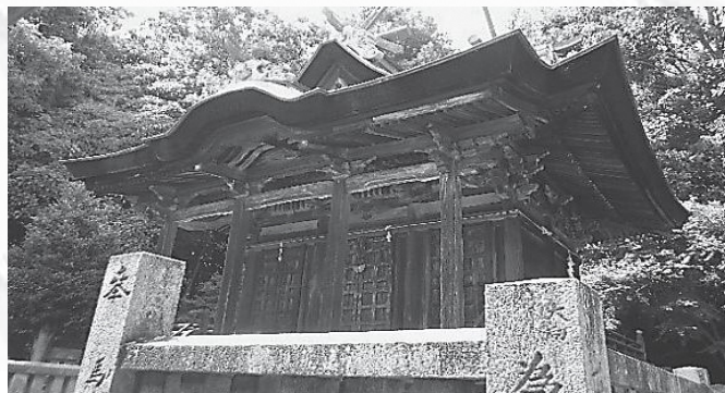
修理を終えた本殿
