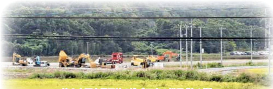
第2宮下産業団地の造成工事の様子(第1期)
