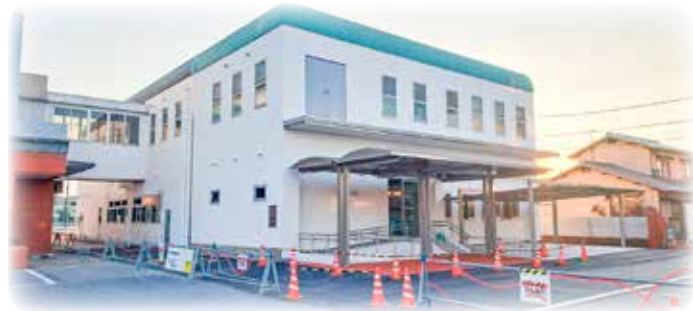
完成間近の本庁舎西棟
