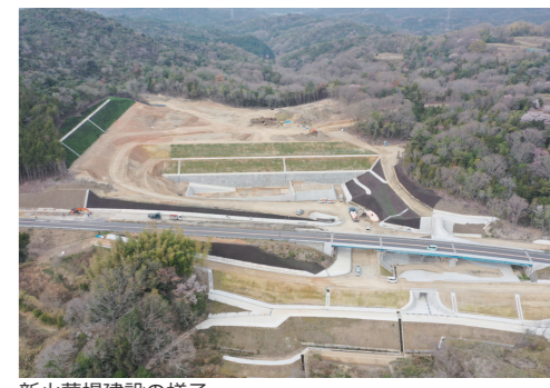
新火葬場建設の様子
