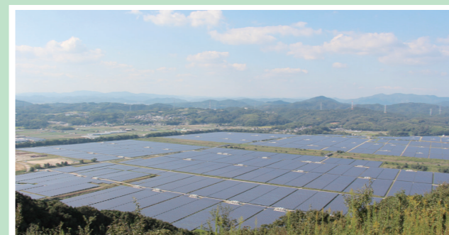
瀬戸内 Kirei 太陽光発電所
