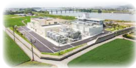
福山浄水場の全景写真
