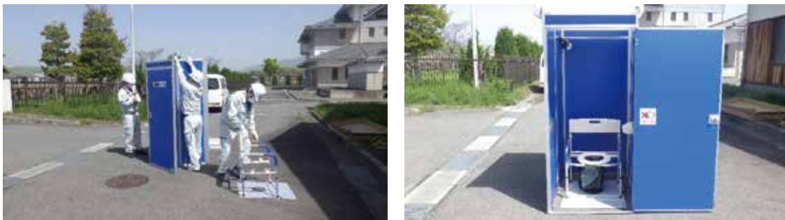
災害時用マンホールトイレ設置訓練
