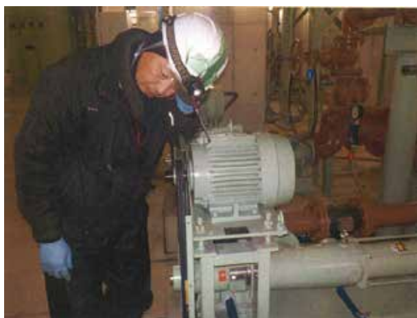
処理場施設における点検作業
