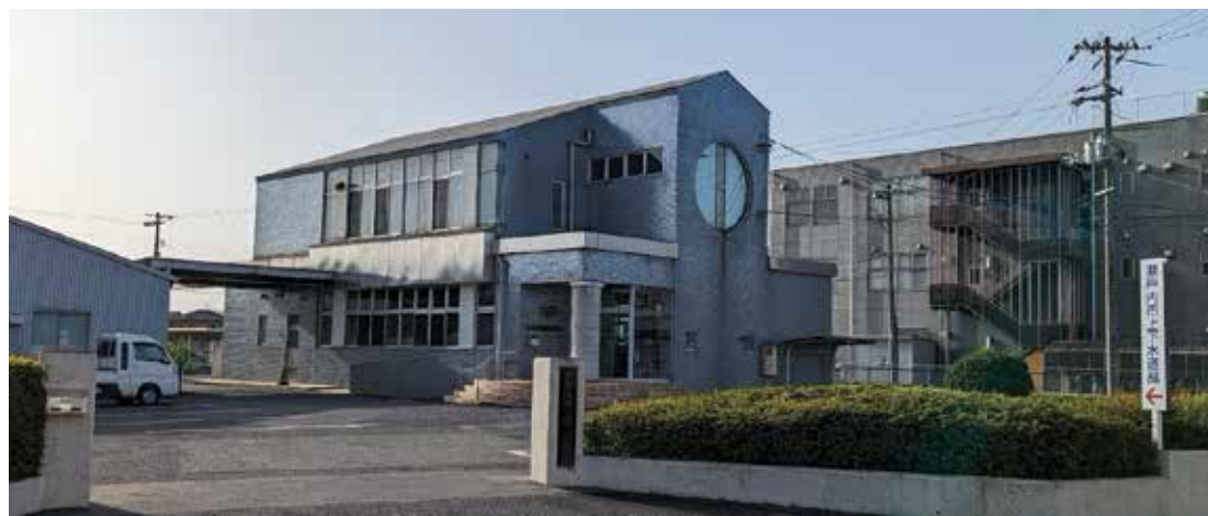
瀬戸内市上下水道部庁舎
