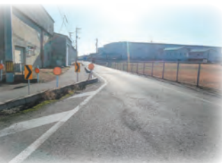
一部狭くなった市道、改良できないか
