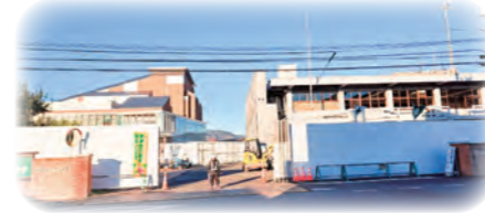
改修中のゆめトピア長船 (今白く覆われている部分がすべてこどもパークになる。正面玄関に向かう進入路も閉ざされる。)
