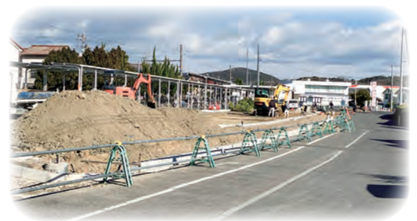
工事が進む駅前整備事業(邑久駅)
