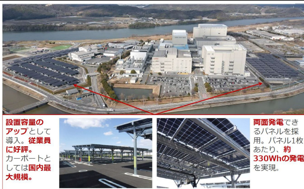
図 3-20 岡山村田製作所の駐車場型太陽光発電設備
