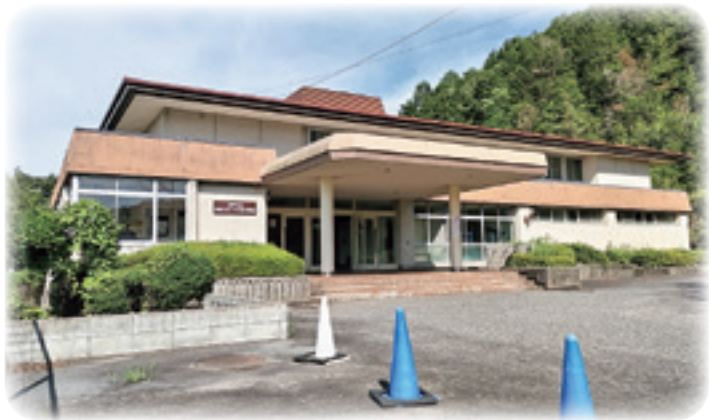
改修工事を行う長船スポーツ公園体育館
