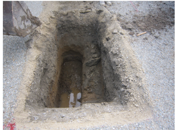
調査区トレンチ西側(西から)
