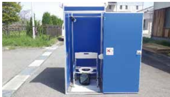
災害時用マンホールトイレ設置訓練
