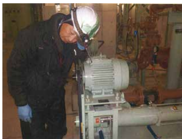
処理場施設における点検作業
