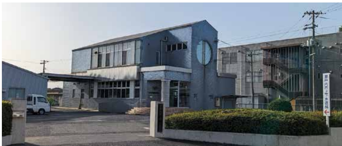
瀬戸内市上下水道部庁舎
