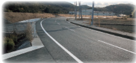
岡山ブルーラインに直結させたい市道南北線
