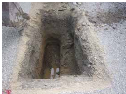
調査区トレンチ西側(西から)
