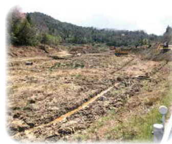
造成中の予定地(邑久町山手・北池)
