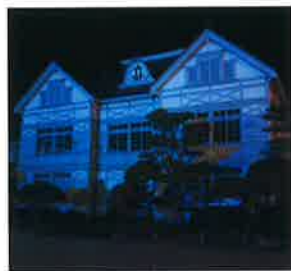
旧遷喬尋常小学校(真庭市)
