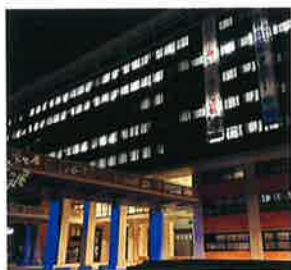
岡山県庁舎ピロティ(岡山市)
