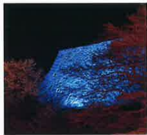
鶴山公園北側城壁(津山市)
