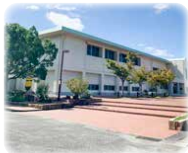
エアコン未設置の邑久B&G体育館
