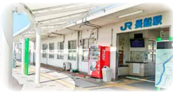
活用が望まれる無人となった駅舎
