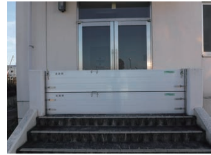
止水板設置事例
