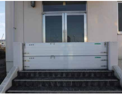
止水板設置事例
