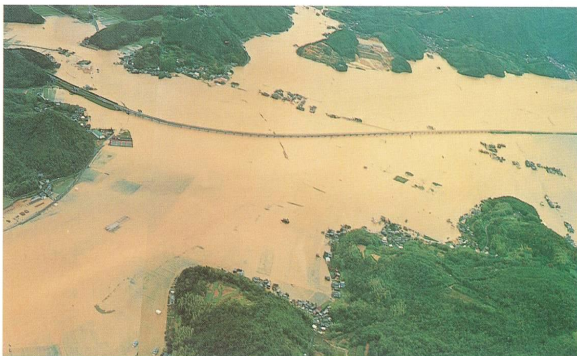
平成2年9月台風19号による洪水被害(邑久町尾張・本庄地内) (岡山県『平成2年9月台風第19号災害誌』)
