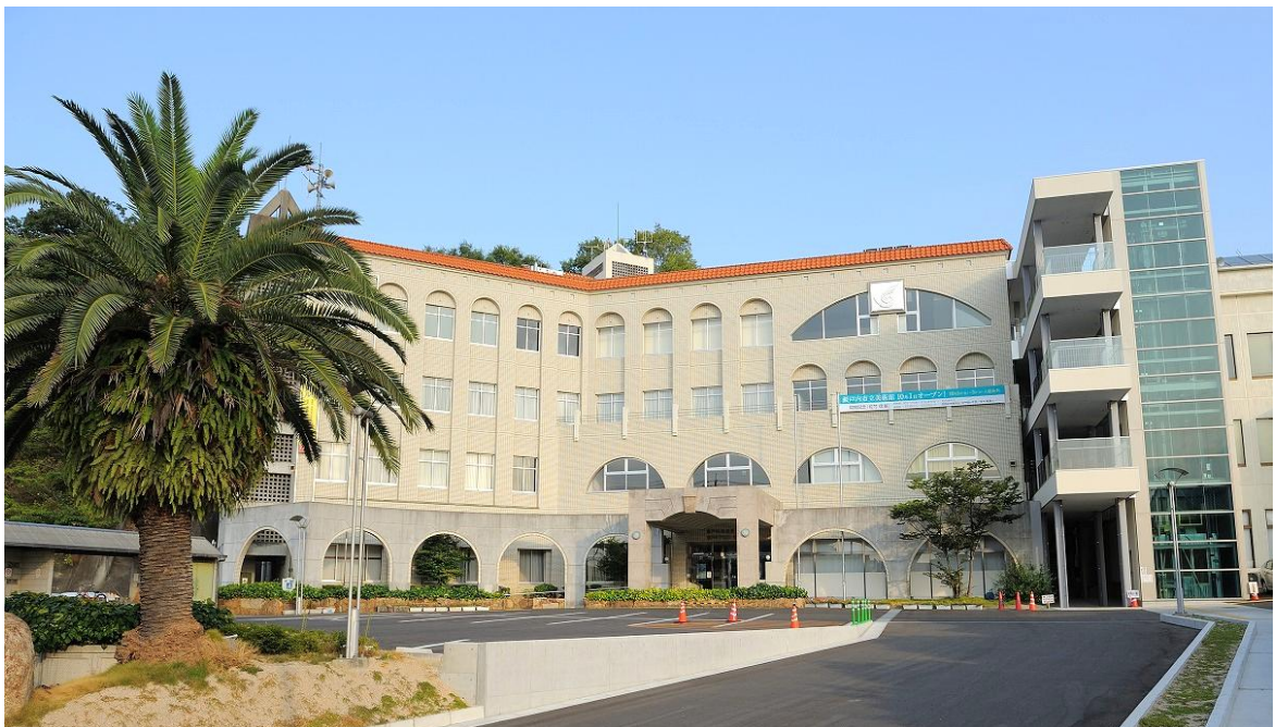
牛窓庁舎外観
