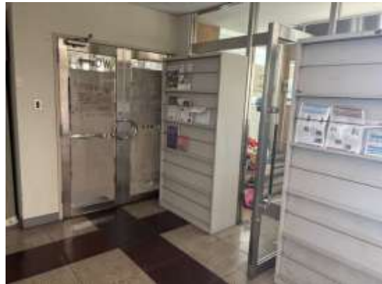
公民館側牛窓海遊文化館接続部
