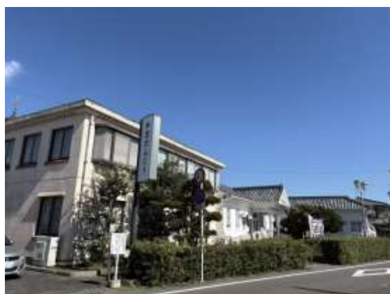
牛窓公民館牛窓分館
