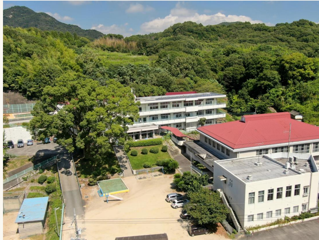
【瀬戸内市立裳掛小学校の外観】
