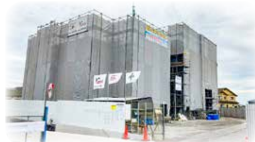
令和9年完成予定の邑久地区市営住宅A棟(邑久町福元)
