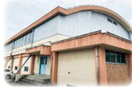
エアコン設置が望まれる小学校体育館(邑久小学校)
